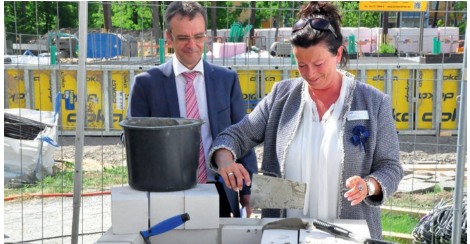
Grundsteinlegung am Krankenhaus Ludwigsfelde-Teltow für den Neubau Bettenhaus, Rettungsstelle und Radiologie
