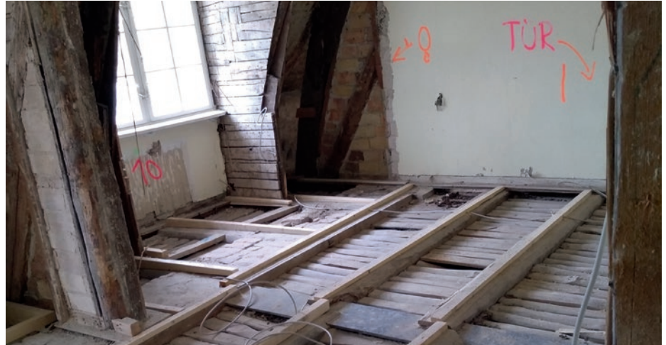
Baustelle Elisabethhaus vor dem Einbau von neuen Zimmern und Bädern
