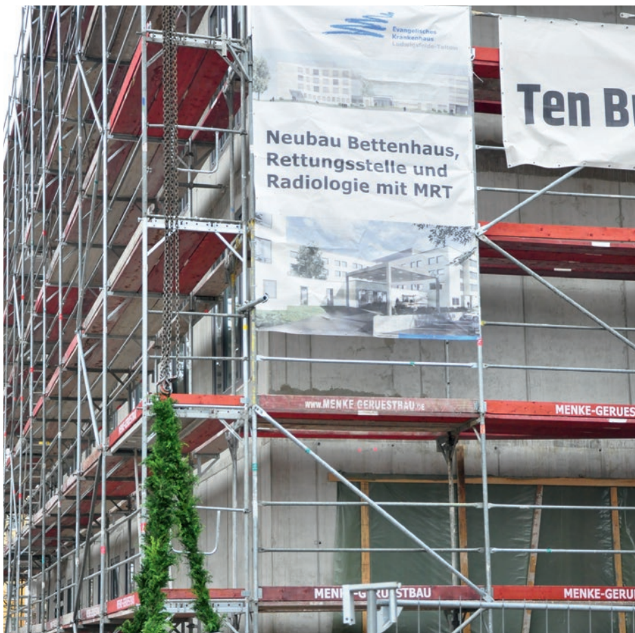
Richtfest am Neubau Bettenhaus, Rettungsstelle und Radiologie in Ludwigsfelde
