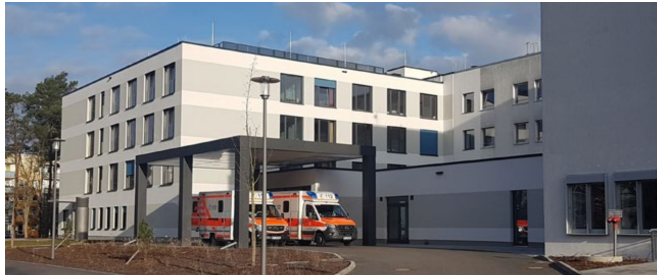
Das neue Bettenhaus mit Rettungsstelle, Bereitschaftspraxis und Radiologie
