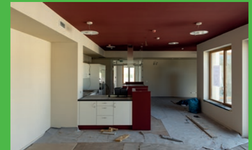
Innenbau im Haus Matthäus
