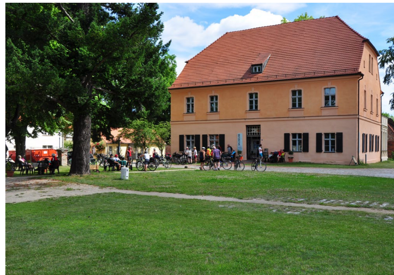
Das Amtshaus wird für die Versorgung der Gäste umgebaut
