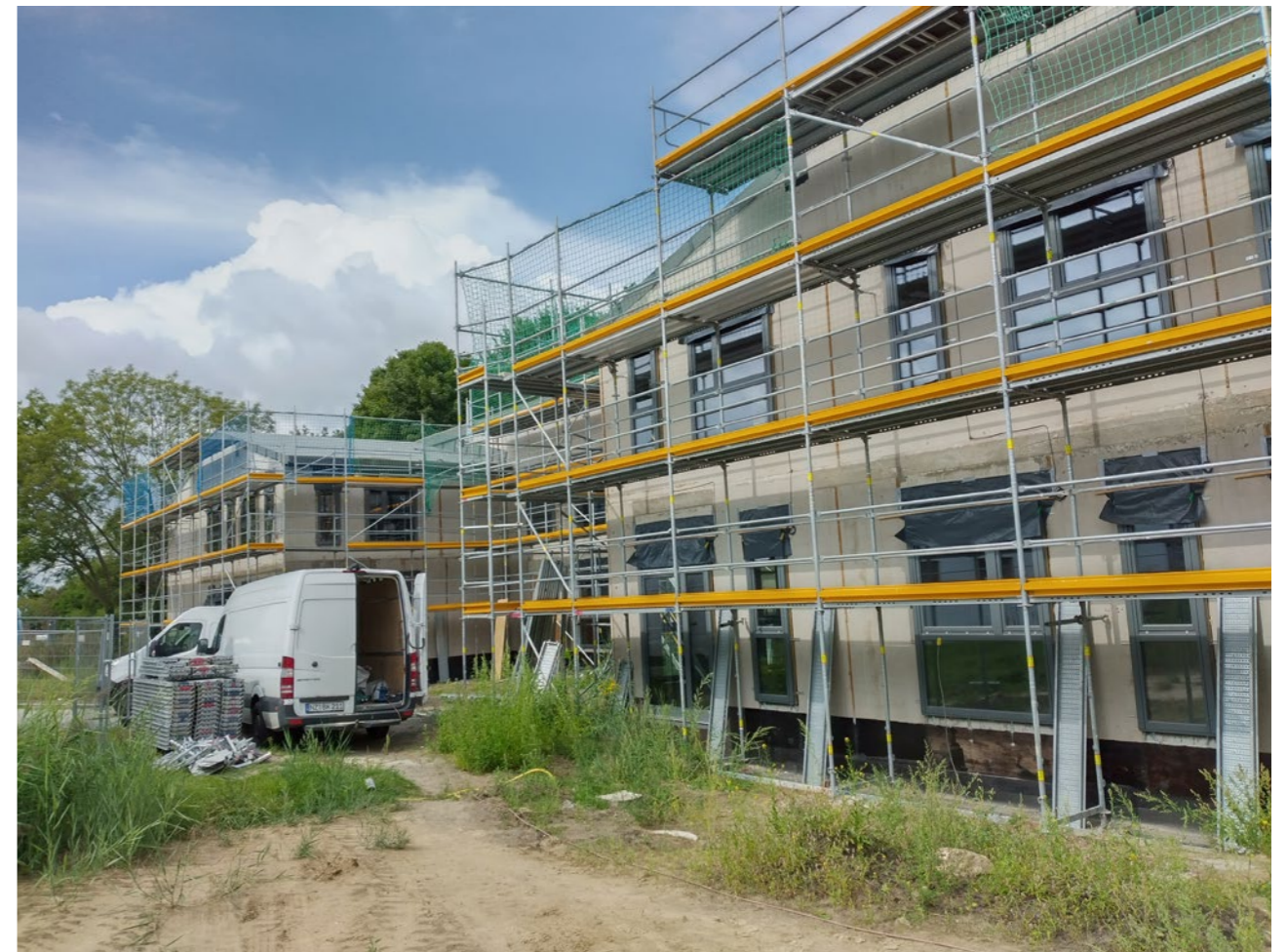
Die neue Kita im Bau
